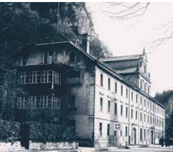
Das ehemalige Krankenhaus in der Walgaustraße.
