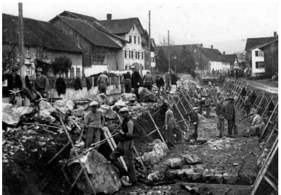
Flussregulierungsarbeiten an der Nafla unter Einsatz von Arbeitslosen 1936.
