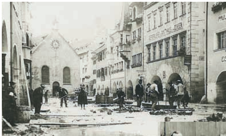
Aufräumarbeiten nach dem Hochwasser 1910 in der Marktstraße. Auf der rechten Bildseite das Gasthaus Ochsen.
