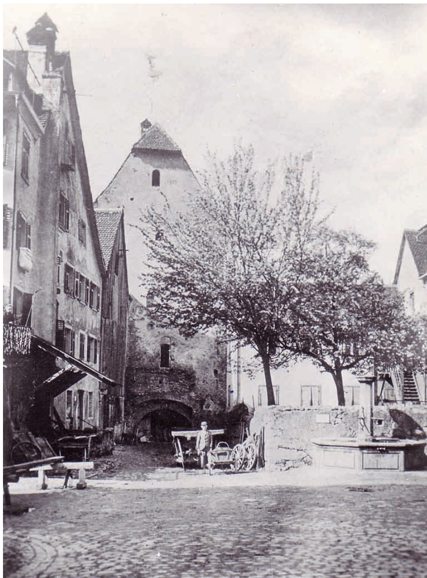
In den Jahren 1828 und 1829 wurde der Vorstadtbrunnen errichtet. Blick aus der Montfortgasse zum Wasserturm.
