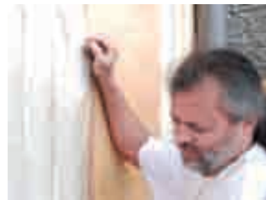
Restaurator Franz Niederhauser beim Restaurieren der Fassadenmalerei.
