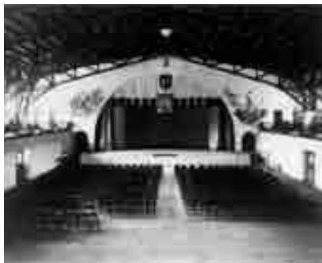
Gut sichtbar ist auf diesem Foto die Balkenkonstruktion der Volkshalle. Die Binder hatten eine Spannweite von 28 Metern.
