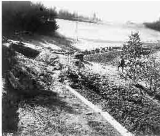
Bau der Straße nach Schüttenacker und Fresch (1927)
