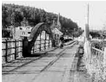
Die alte Brücke zwischen Gisingen und Nofels, die 1973 abgebrochen wurde.
