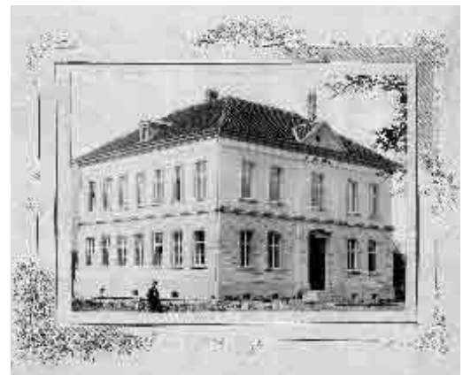
Die 1900 errichtete Volksschule in Nofels
