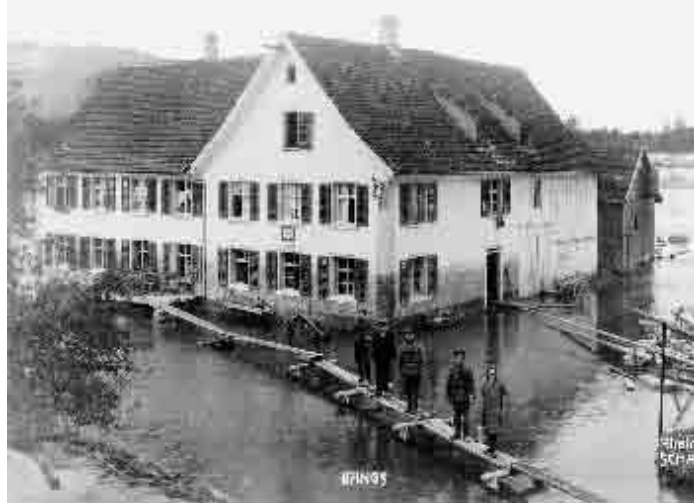
Rheinhochwasser 1927: Der Gasthof Stern steht unter Wasser und kann nur über Holzstege erreicht werden.
