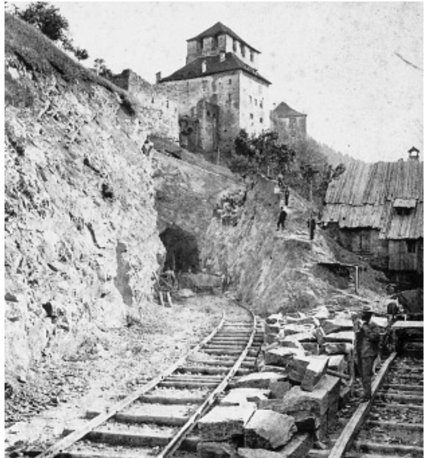
Bau des Schattenburgtunnels um 1870
