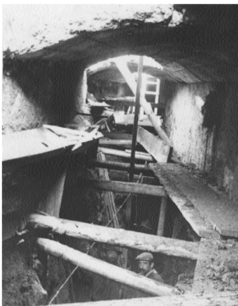
Bau der Kanalisation vom Entenbächle unter dem Alten Spital (heute Rathaus), 1912
