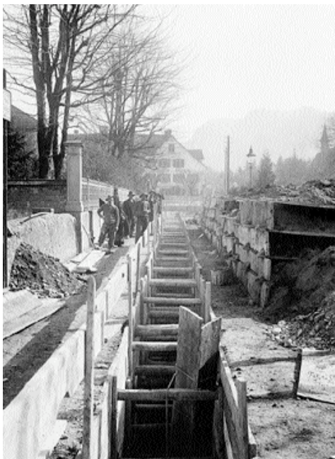
Der letzte Abschnitt im Rahmen der Kanalisation der Altstadt (außerhalb der Stadtmauern am Hirschgraben, 1913).
