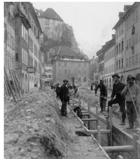
Kanalbaustelle in der Neustadt.
