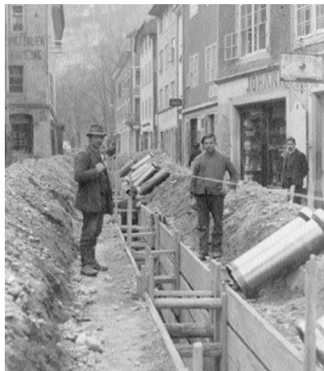
Arbeiten am Gaiszipfel.
