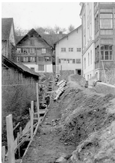
Kanalbau in der Dreesstraße. Rechts im Bild die heutige Bäckerei Schnell.
