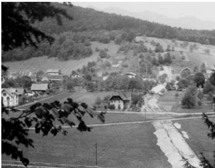
Panzergraben in Altenstadt. In der Bildmitte ein Bagger, der zum Ausheben und Zuschütten des Grabens in Verwendung stand. (Foto: Heimatkundeverein Altenstadt)
