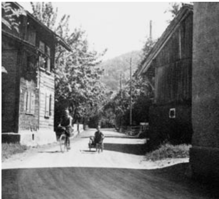
Die Hauptstraße in Gisingen nach dem Ausbau 1937.
