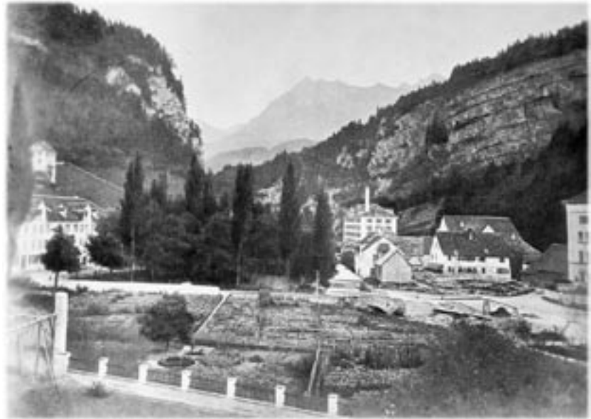
Blick auf den Holzlagerplatz und die Ziegelhofgärten, eine Schrebergartenanlage, die sich im Bereich des heutigen Montforthauses befand (vor 1885).
