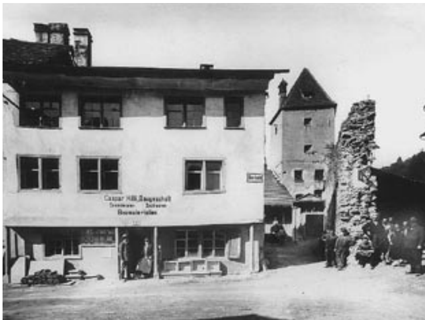
Die Baufirma Hilti an ihrem heutigen Standort
