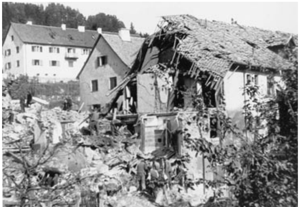
Zerstörtes Wohnhaus in der Blasenberggasse
