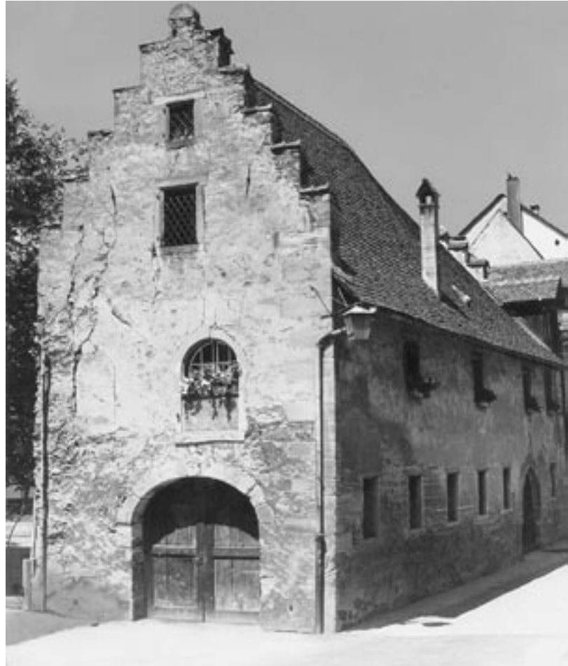
Das Zeughaus vor der Restaurierung ca. 1970
