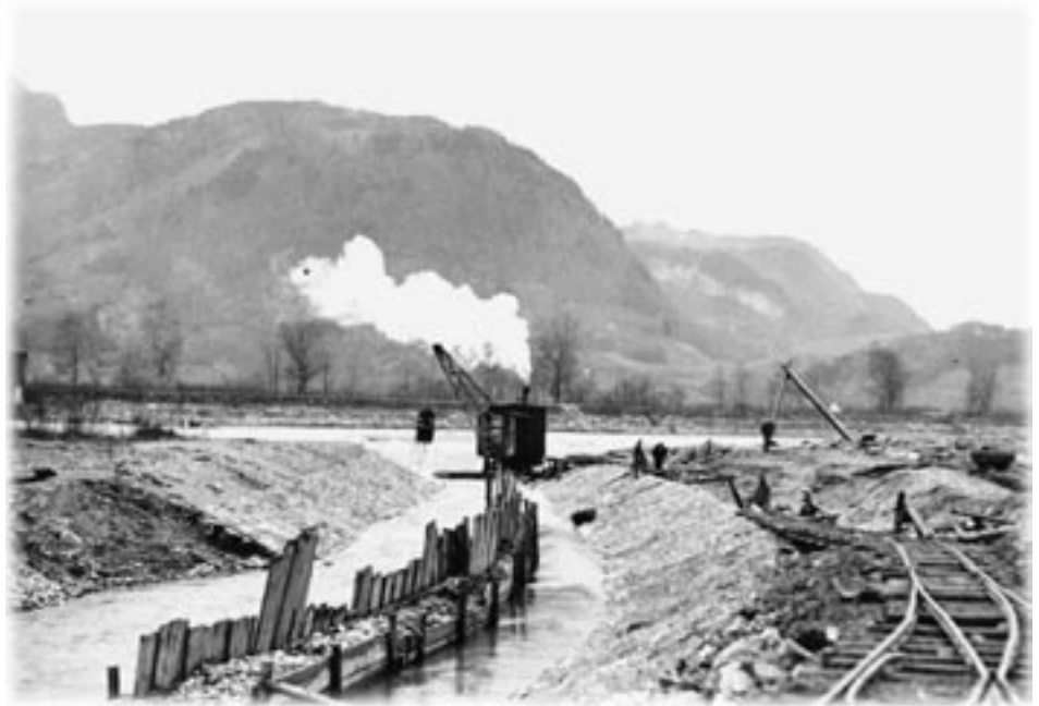
Ein mit Dampf betriebener Bagger am Spiersbach (1933) (Foto: Stadtbaumeister Karl Puchner)
