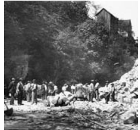
Trentiner Arbeiter bei der Verbreiterung der Straße 1914 - zu erkennen an Hut und „Murajagga“.
