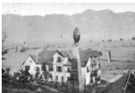
Durch den Betrieb des Windrades im Vordergrund wurde das Wasser hochgepumpt.
