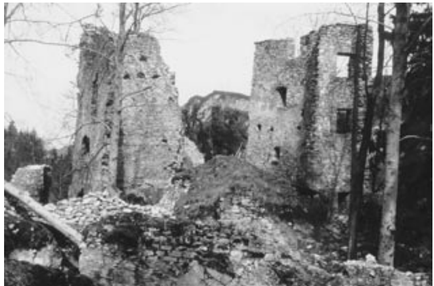
Die Ruine des ehemaligen Staatsgefängnis Alt Ems in den 60er-Jahren.
