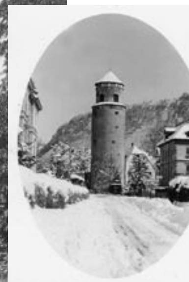
Rechts neben dem Katzenturm das Zinshaus, das erste Miethaus in Feldkirch, das 1968 abgebrochen wurde.
