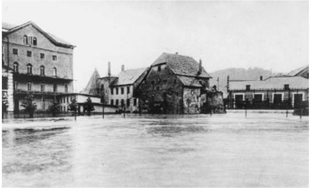
Der Leonhardsplatz mit Mühle- tor, E-Werk und alter Stella
