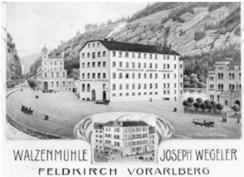
Die Wegeleermühle lieferte als Privatkraftwerk bereits vor 100 Jahren Strom
