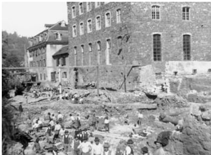
Der Aushub zum Bau des E-Werks um 1905
