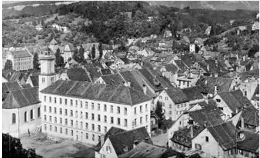
1860 wurde das Gymnasium mit der sogenannte „Kiste“ ein für damalige Verhältnisse großzügiger Schulbau in Betrieb genommen
