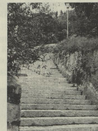
Die sanierte Bettlerstiege 1983
