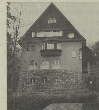
Reiner Heimatstil beim Evangelischen Pfarrhaus: hoher Giebel, Erker und grobes Mauerwerk der Sockelzone.
