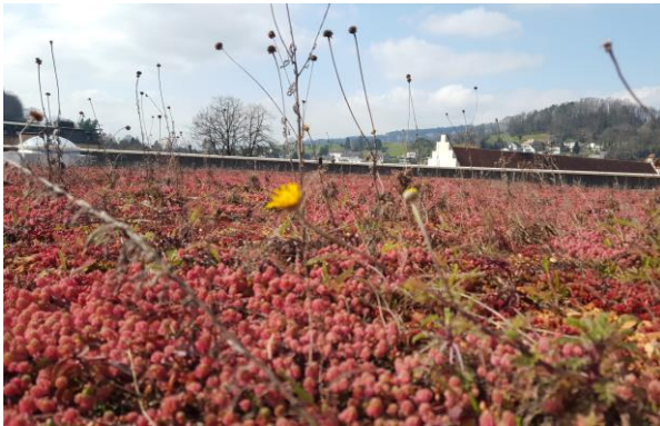
Montforthaus, Gründach mit Blick nach Nordwesten
