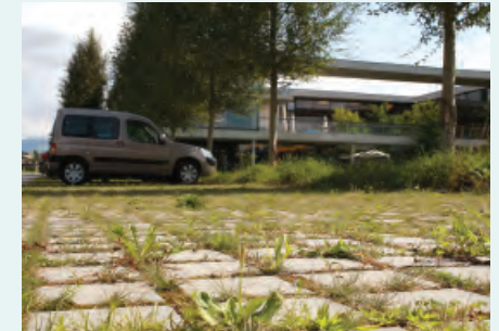
Damit sich Grundwasser neu bilden kann, muss Regenwasser im Boden versickern können. Im Bild als Beispiel einer versickerungsfähigen Alternative zur Parkplatzbefestigung der mit Pflastersteinen ausgestattete Vorplatz beim Haus Tosters.
