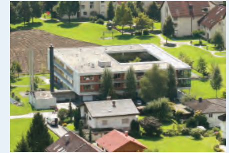
In der Biomasseheizzentrale im Nahwärmenetz beim «Haus Tosters» sorgt eine eigene, mit innovativer Technik ausgestattete Filteranlage, für eine Reinigung des Rauchgases von Staubpartikeln.
