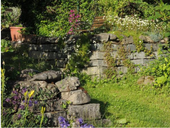
Gesteinsfugen sollten nie mit Mörtel geschlossen werden.
