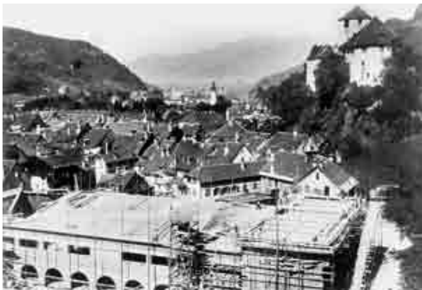
Blick auf den Rohbau der Volkshalle. Das Mauerwerk ist bereits fertig und an der Dachkonstruktion wird gerade gearbeitet. Sommer 1926.
