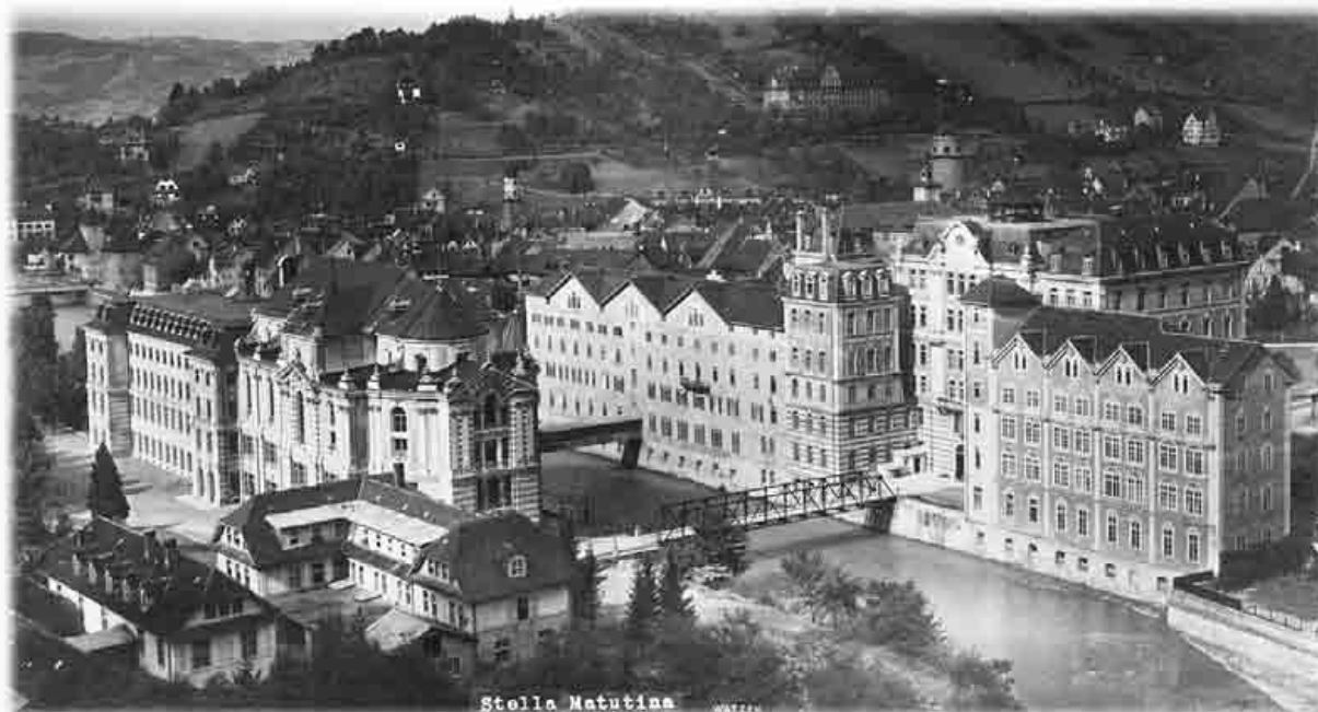
Blick vom Stadtschrofen auf den beeindruckenden Gebäudekomplex der Stella Matutina links und rechts der Ill.
