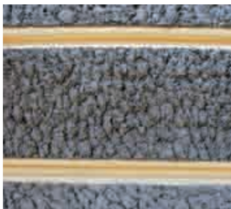
Der Kellenwurfputz zeichnet sich dadurch aus, dass der Verputz mit einer kleinen Rundkelle angeworfen wird und dadurch für eine stark belebte Oberfläche sorgt.
