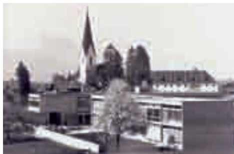
Die neue Volksschule wurde 1966 bzw. 1973 eröffnet.
