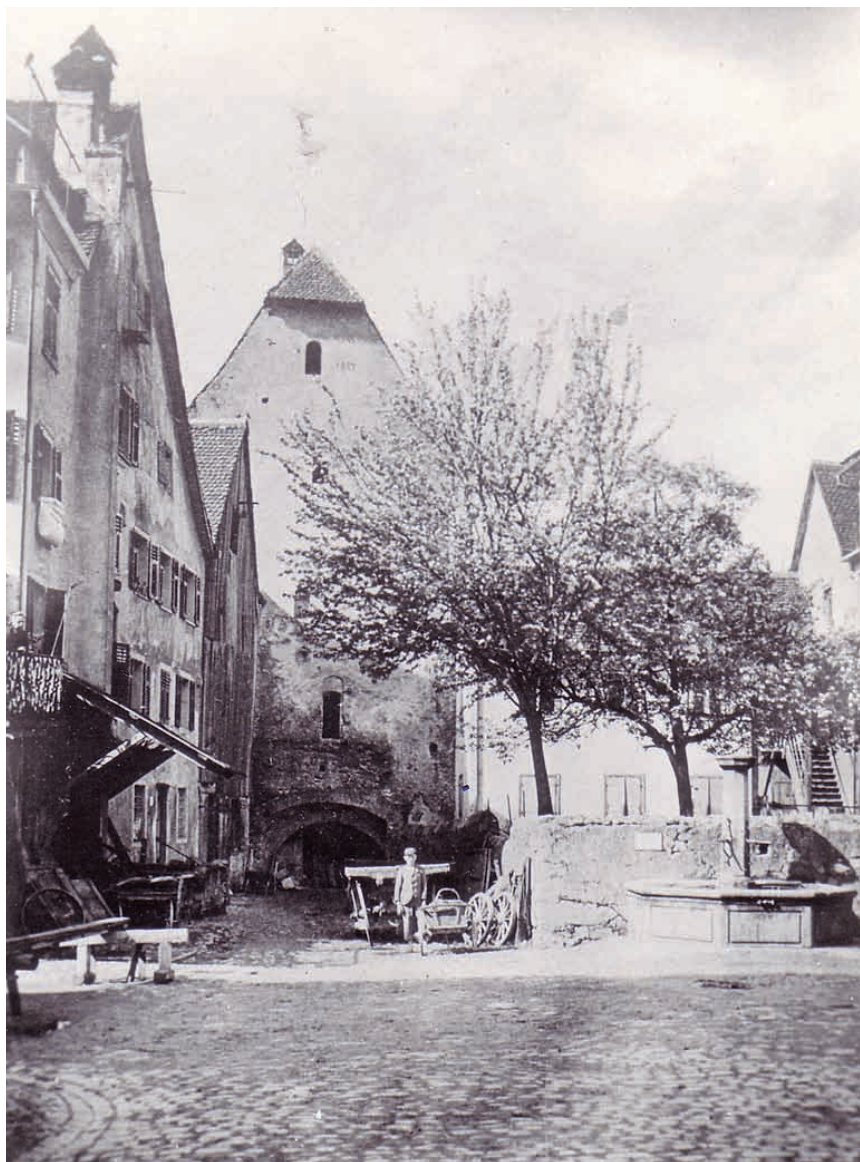
In den Jahren 1828 und 1829 wurde der Vorstadtbrunnen errichtet. Blick aus der Montfortgasse zum Wasserturm.
