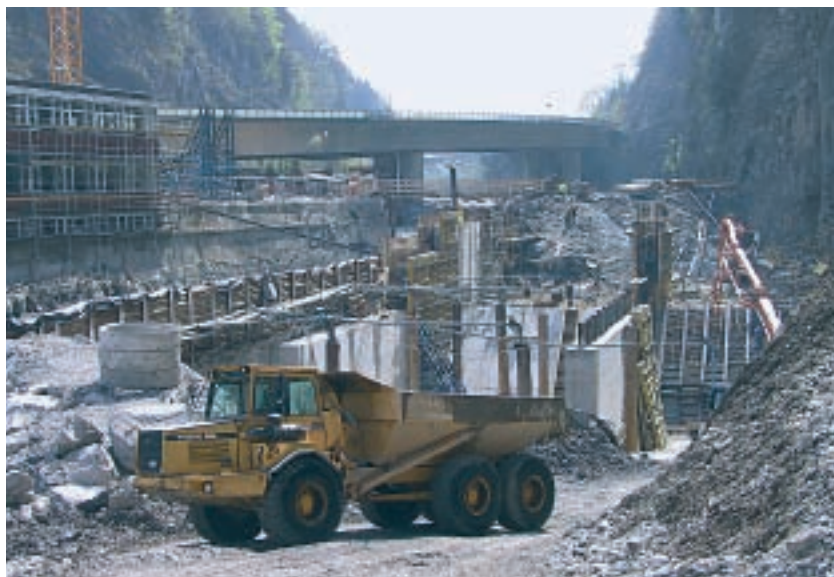
Insgesamt 21 Monate wurde am Kraftwerk Hochwuh in der Felsenau gebaut.
