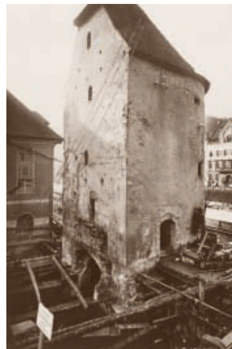
Der mittelalterliche Wasserturm wurde im Jahr 1924 für die Kanalverlegung auf Stützen gestellt und vollständig untertunnelt.
