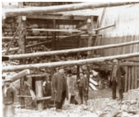
Bau des Überlaufkanals bei der Firma Ganahl Anfang des 20. Jahrhunderts
