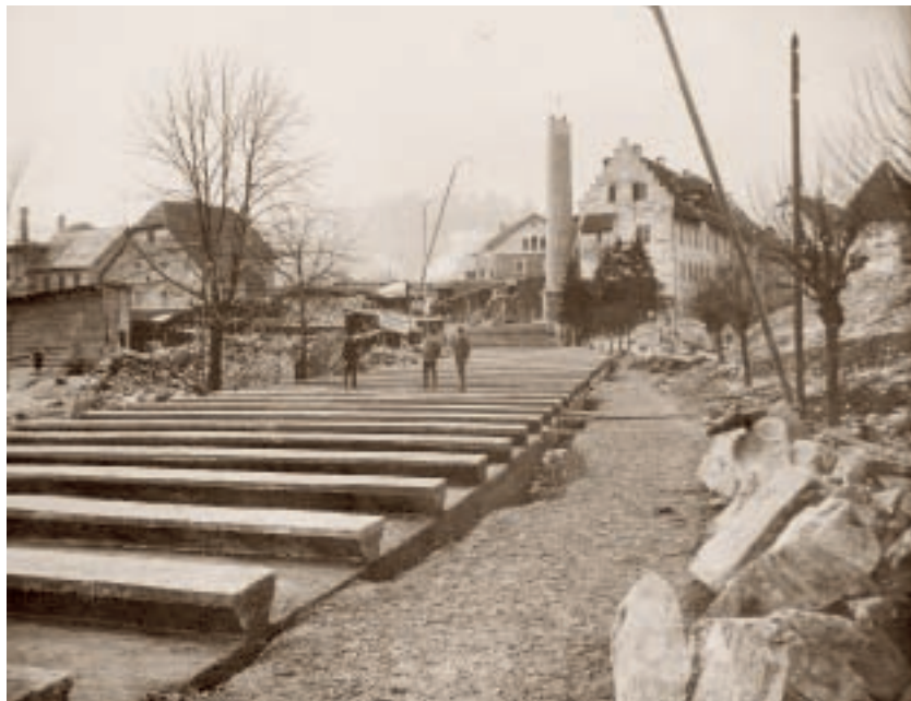
Abdeckung des Mühlekanals - dem Wasserzulauf zum Kraftwerk - im Bereich des Leonhardsplatzes, im Hintergrund der Rohbau des Kraftwerks und des Schornsteins (1905)
