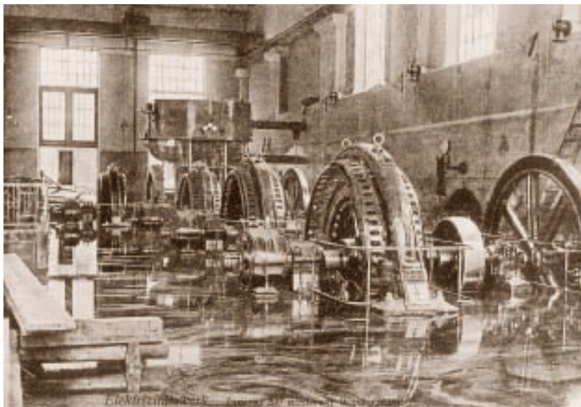
Überfluteter Turbinenraum während des Hochwassers von 1910
