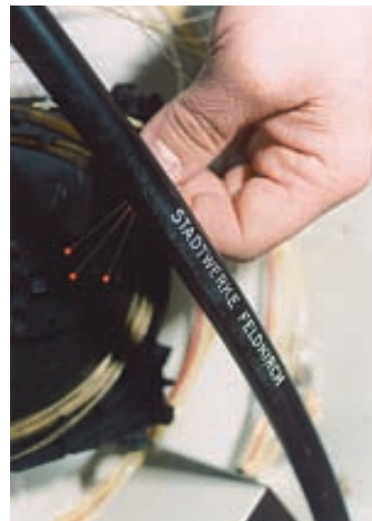
Unscheinbare Glasfaserkabel ermöglichen eine Übertragung großer Datenmengen mit Geschwindigkeiten bis zu 2,5 Gbit/s.
