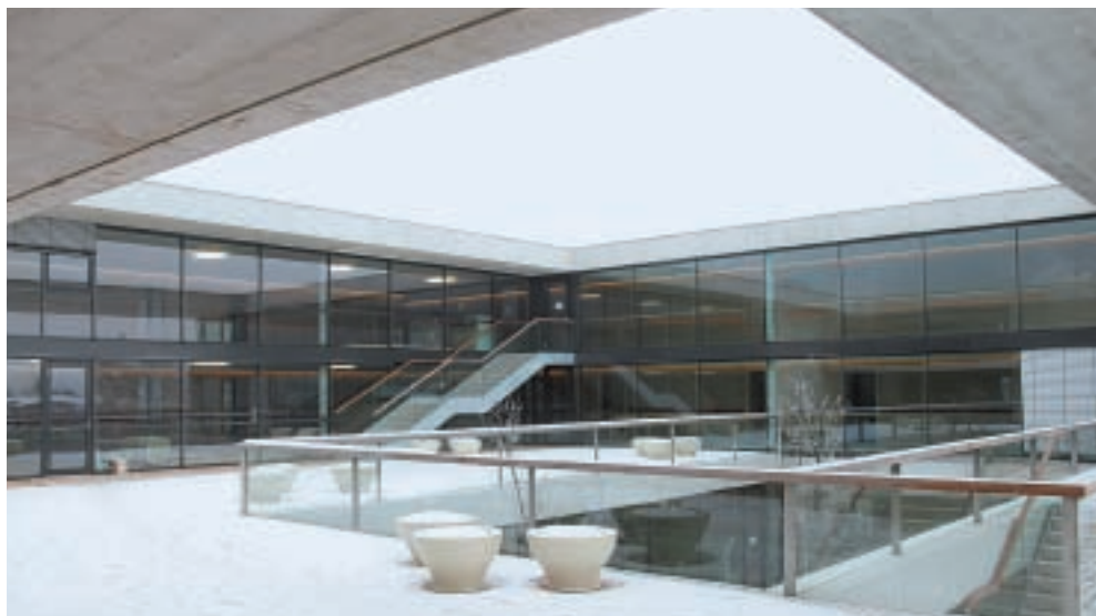
Der Innenhof stellt das wichtigste Element der Planung dar.
