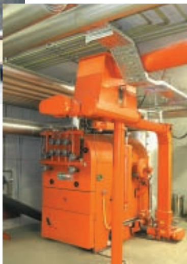
Eine Hackschnitzelanlage versorgt das Haus Tosters vor Ort mit umweltfreundlicher Energie aus heimischem Holz.
