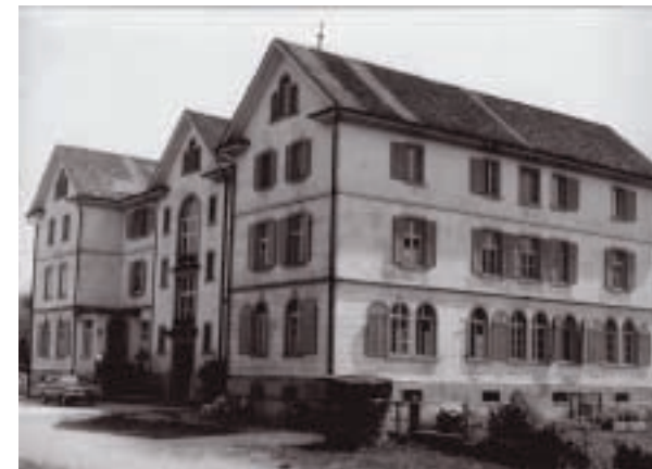
Aufgrund akuten Platzmangels wurde in den Jahren 1881/82 das neue Versorgungsheim in der Magdalenastraße in Nofels gebaut.
