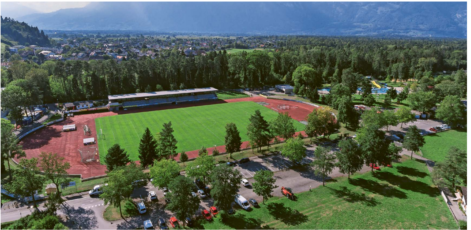
Die Laufbahn im Waldstadion wird saniert und ist im nächsten Sommer wieder einsatzbereit.
