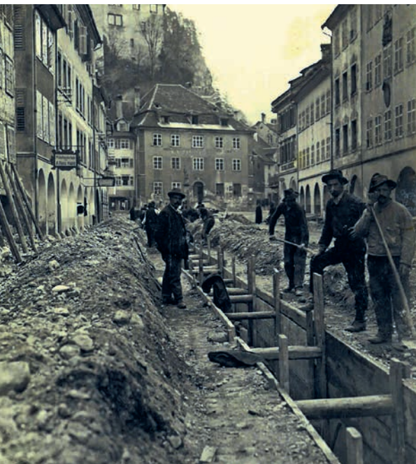
Vor über 100 Jahren wurden die Kanalarbeiten in der Neustadt fertiggestellt.
