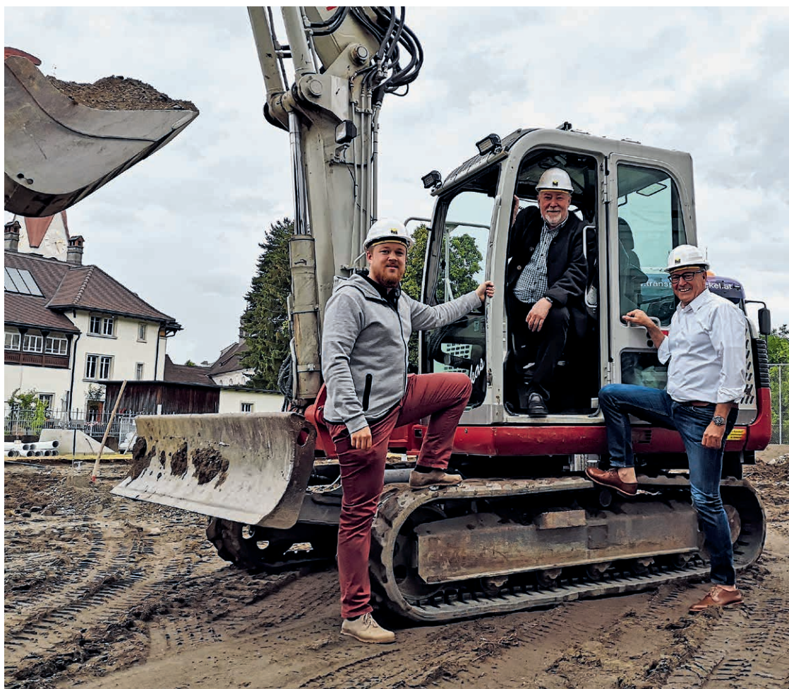
Ortsvorsteher Nemetschke, Alt-Ortsvorsteher Mähr und Bürgermeister Matt waren beim Start für den Bau der Ersatzschule vor Ort.
