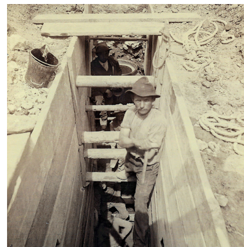
Die Baugruben waren metertief und die Arbeiter benutzen Schaufeln und Pickel.
