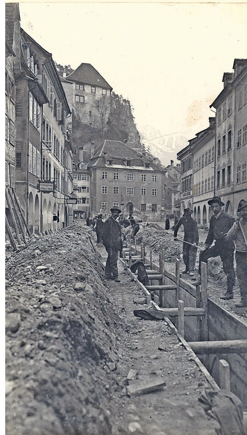
Die Kanalarbeiten in der Neustadt wurden 1912 fertiggestellt.
