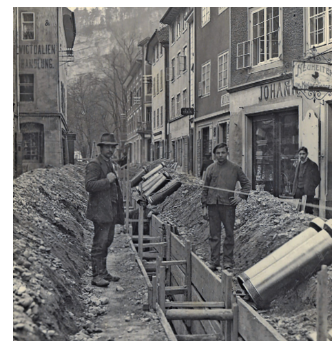
Die vor über 100 Jahren verlegten Rohre (im Bild Gaiszipfel) sind teils heute noch in Verwendung.
