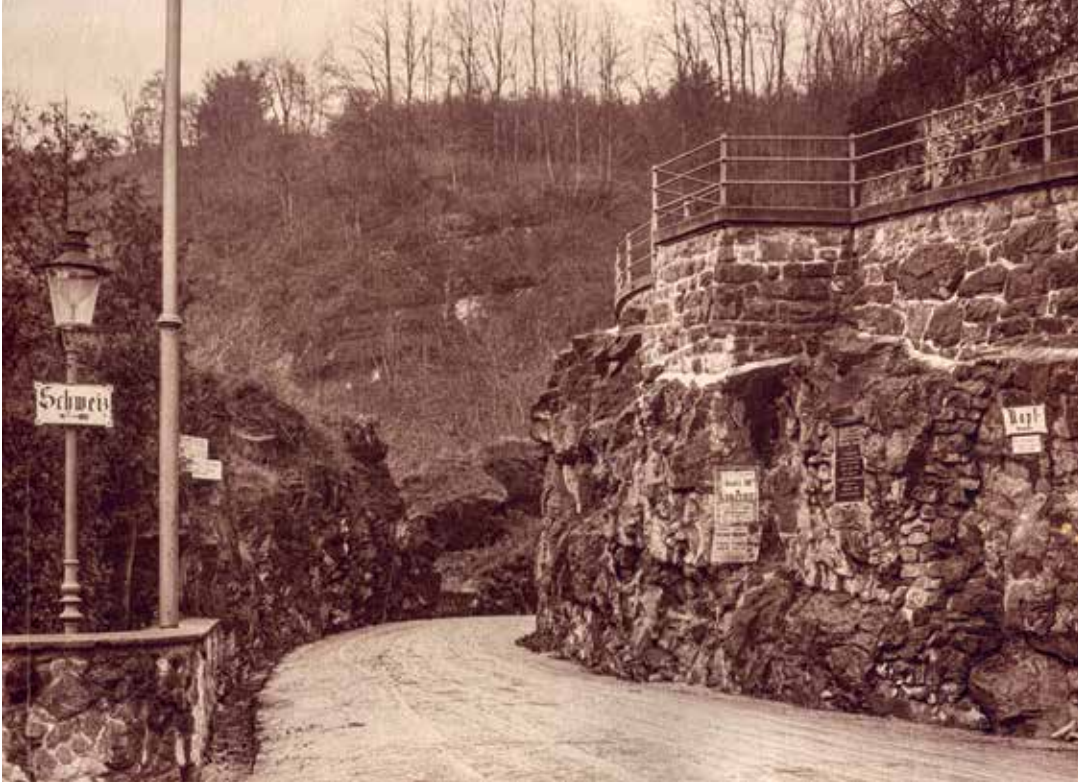
Die Kapfstraße vor dem Ausbau
