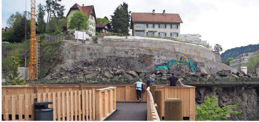
Die Aussichtsplattform direkt neben der Behelfsbrücke bietet einen guten Blick auf die Bautätigkeiten.
