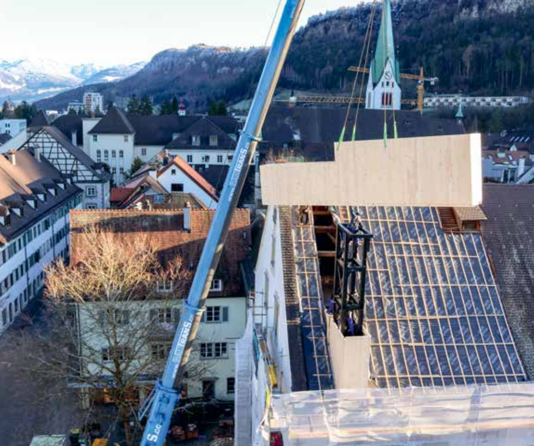
< Die großen Stahl- und Holzelemente wurden mit Hilfe von zwei Mobilkränen am Dach des Palais Liechtenstein montiert.
