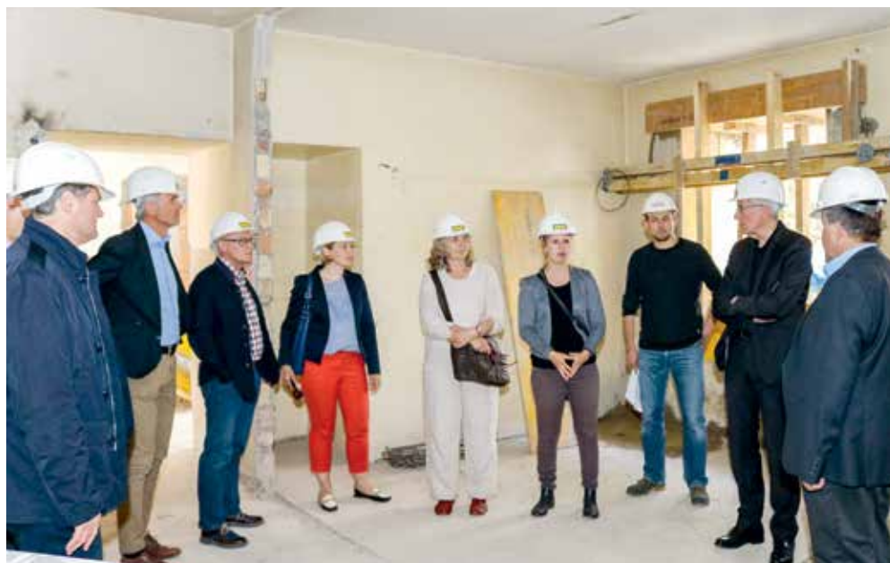
< Die Mitglieder des Feldkircher Stadtrats beim Lokalaugenschein auf der Jugendhaus-Baustelle.
