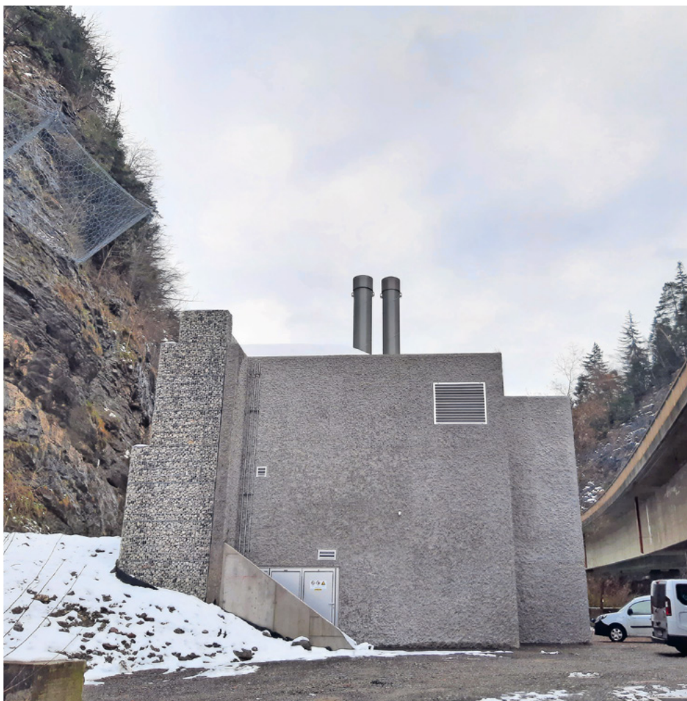
Das neue Heizwerk in der Schießstätte versorgt bereits erste Gebäude in der Altstadt mit Wärme.
