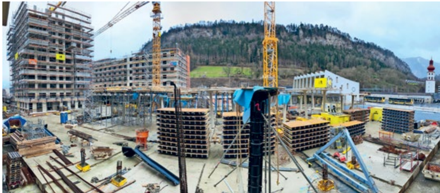
Die Bauarbeiten an der Bahnhofcity schreiten zügig voran.
