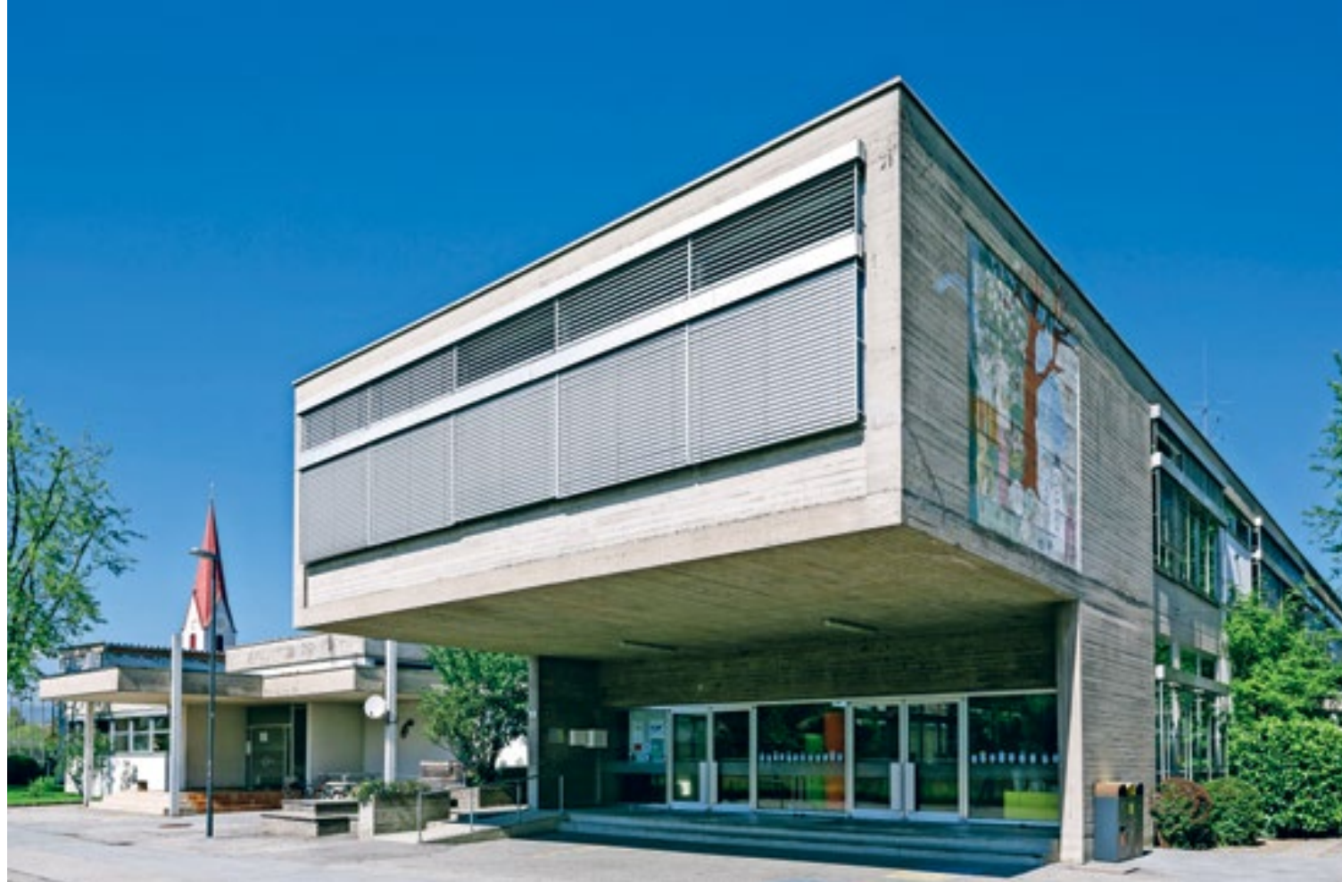
Für die Volksschule Altenstadt wurde ein modernes Raum- und Funktionsprogramm konzipiert. Höchste Qualität ist auch bei der nachhaltigen, baulichen Umsetzung gefragt.
