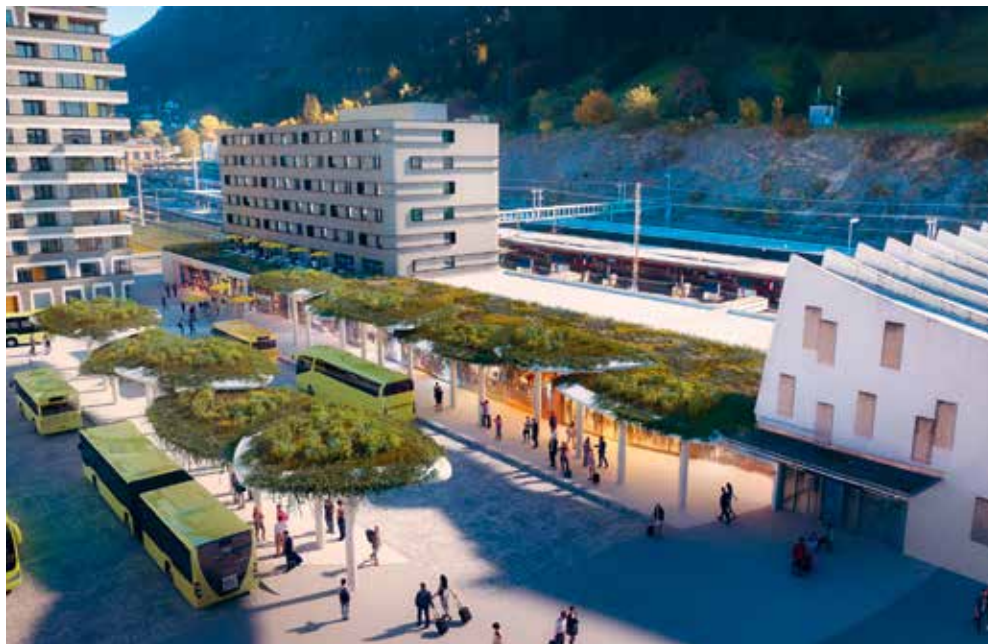
Nach Fertigstellung der Tiefgarage bleibt der Bahnhofsvorplatz Busbenutzern, Fußgängern und Radfahrern vorbehalten.
