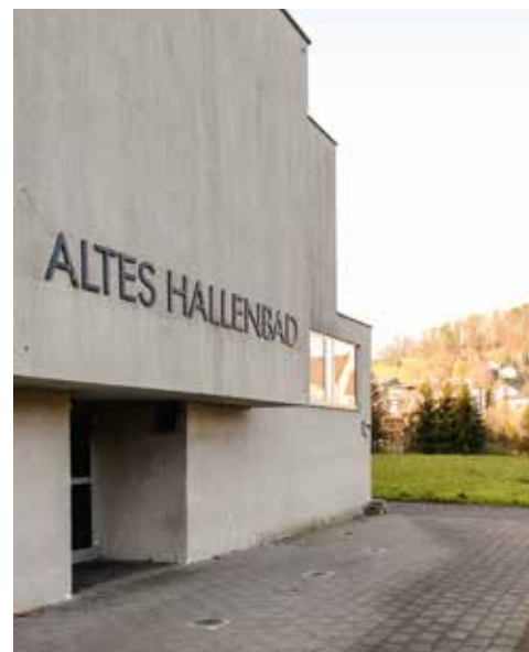
Beim Alten Hallenbad werden ein Lagerraum und ein Personen- und Lastenaufzug errichtet.
