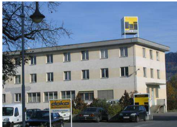
Werbung als leuchtender Würfel auf einem Flachdach in Altenstadt (von der WVO erfasst; nicht zulässig).
