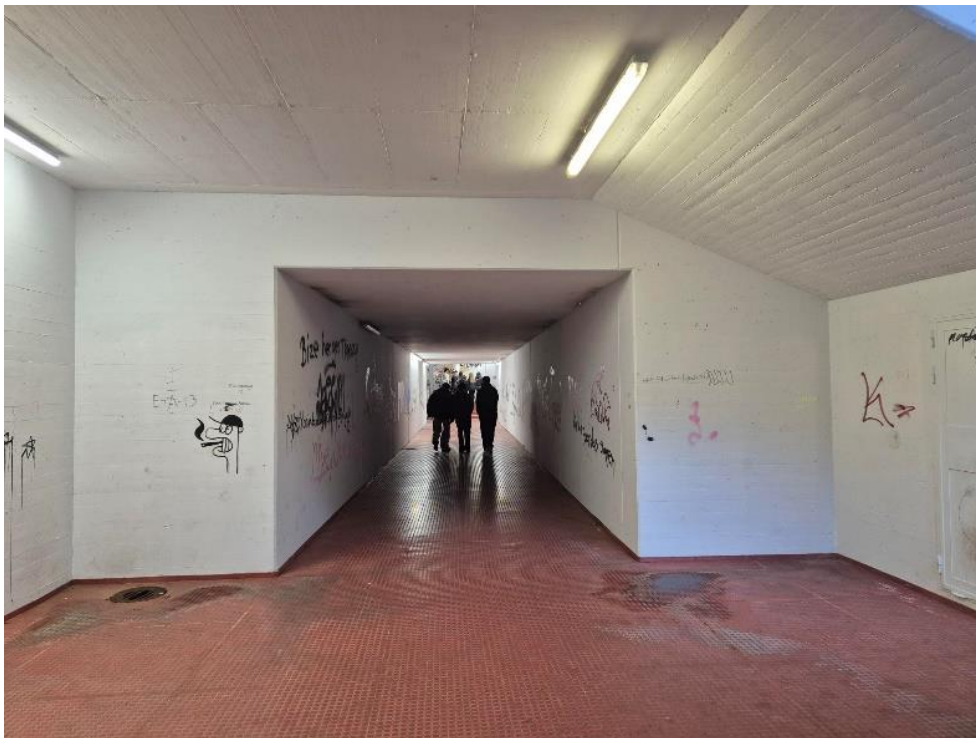
Ansicht Unterführung | Foto: Stadt Feldkirch
